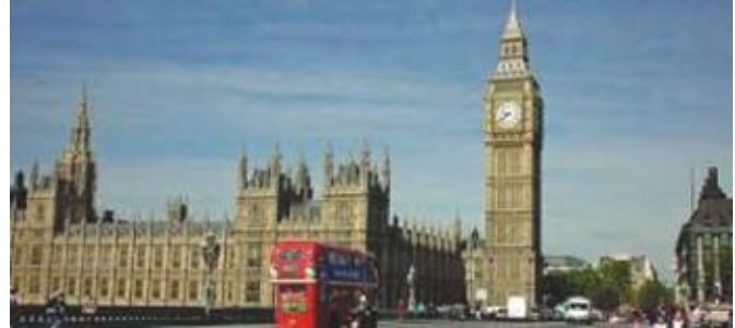
του Ρολογιού αποτελείται από πλινθοδομή με άμμο χρωματισμένα με Anston επένδυση ασβεστόλιθο. Το υπόλοιπο του ύψους του πύργου είναι πλαισιωμένο κωδωνοστάσιο από χυτοσίδηρο. Ο πύργος είναι θεμελιωμένος σε πέδιλο μήκους 15 μέτρων (49 πόδια), από 3 μ. (9,8 ft) πάχους μπετόν, σε βάθος 4 μέτρα (13 πόδια) κάτω από το επίπεδο του εδάφους. Οι τέσσερις πίνακες του ρολογιού βρίσκεται 55 μέτρα (180 πόδια) πάνω από το έδαφος. Ο εσωτερικός όγκος του πύργου είναι 4.650 κυβικά μέτρα (164.200 κυβικά πόδια).
